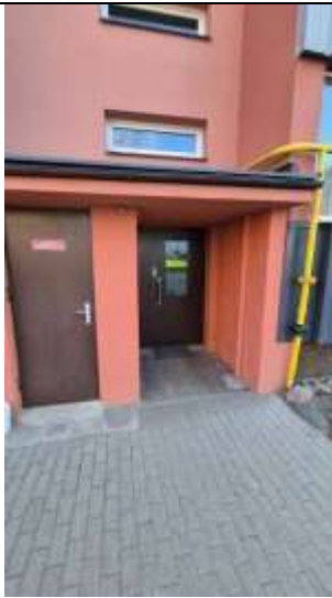
Kāpņu telpas ārdurvis
